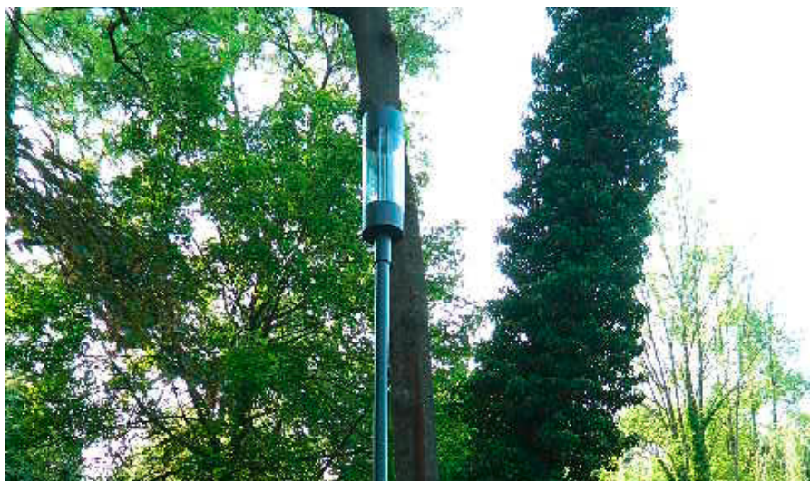
Mit hocheffizienter LED-Technik modernisierte Außenbeleuchtung.
