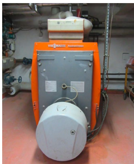
Alter Ölkessel / neuer Holzkessel
