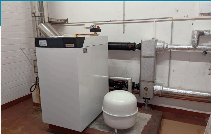
Moderne Brennwerttechnik ersetzt die alten Heizkessel.
