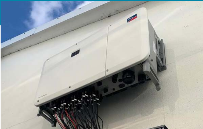
Multistring-Wechselrichter zur Anpassung des PV-Stroms an die Netzfrequenz von 50 Hz.
