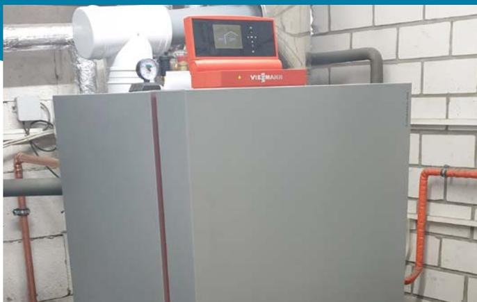
Das moderne Gas-Brennwertgerät ist das Zentrum der Heizungsanlage mit Abgaswärmerückgewinnung.
