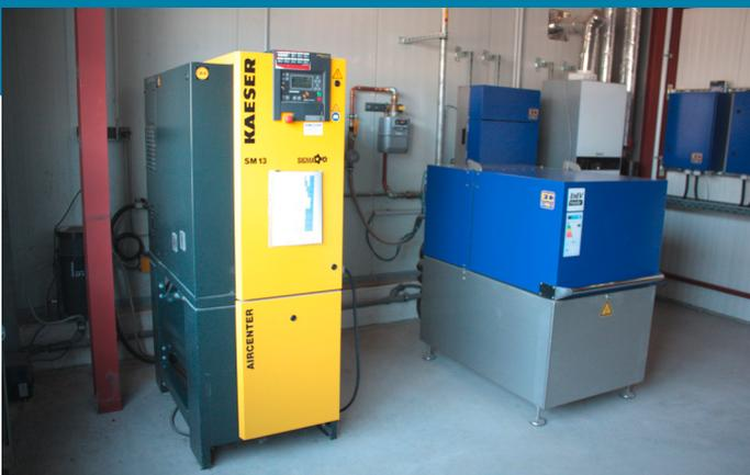
Dieses moderne Blockheizkraftwerk mit Kompressor erzeugt Strom und Wärme.
