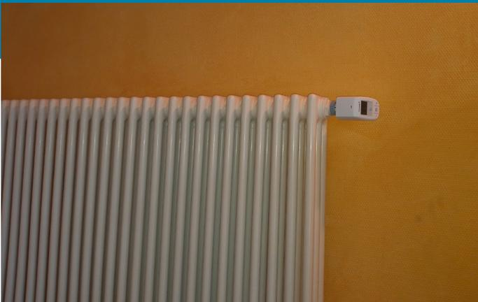
Die Thermostate der Heizkörper werden über ein zentrales Temperatur-Management-System gesteuert.
