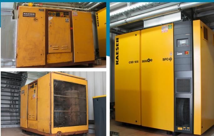
Alte Druckluftanlage (links) neuer frequenz geregelter Druckluftkompressor (rechts)
