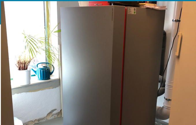
Der alte Niedertemperaturkessel wurde durch diesen neuen Gasbrennwertkessel ersetzt.
