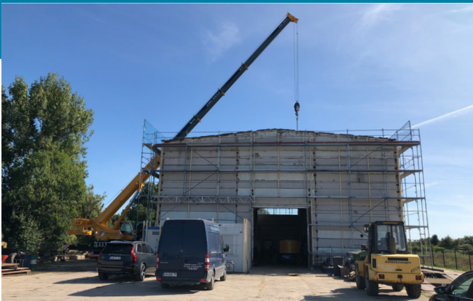
Das Gebäude während der umfangreichen Modernisierung
