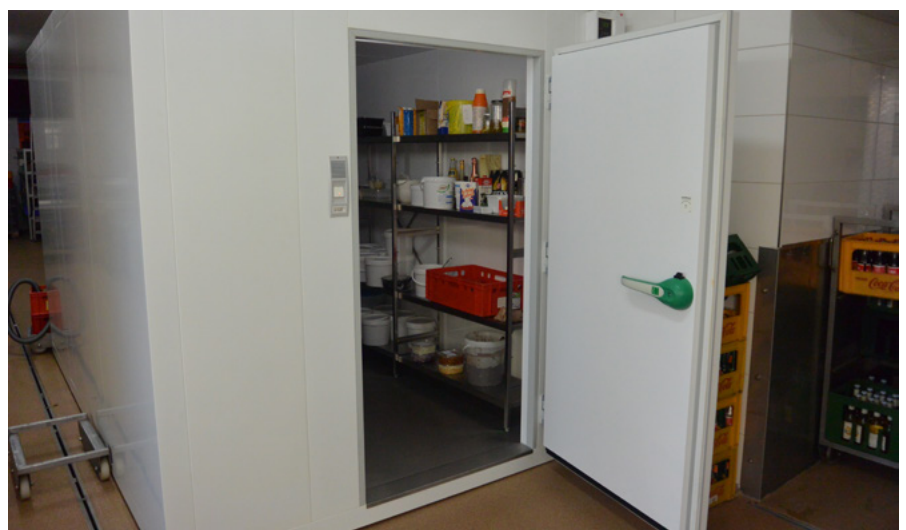
Neubau des Kühlraumes mit hocheffizienter Kühltechnik.
