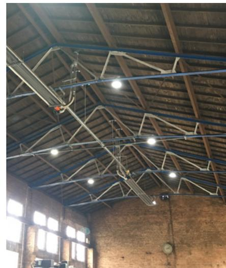
Neue effiziente LED-Hallenbeleuchtung und Deckenheizung unter neu gedämmtem Hallendach.
