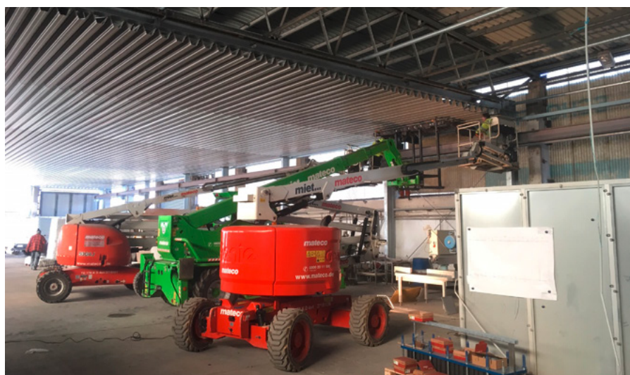
Einzug der Stahlkonstruktion während der Hallensanierung.
