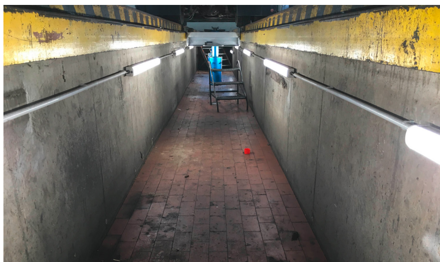
Mit hocheffizienter LED-Beleuchtung modernisierte Fahrzeuggrube
