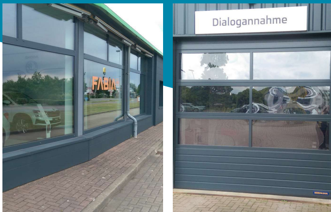
Neue Fenster und Tore verhindern, dass Wärme verloren geht.
