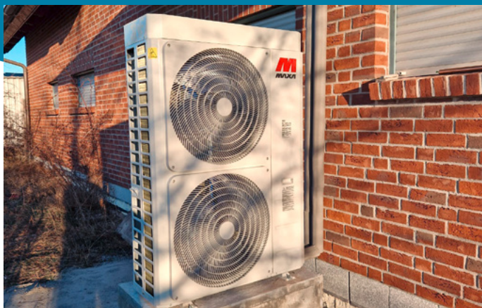
Eine neue Wärmepumpe ersetzt die alte Heizungsanlage.
