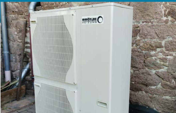
Energieeffiziente Wärmepumpe zum Betrieb der Warmwasserheizung.
