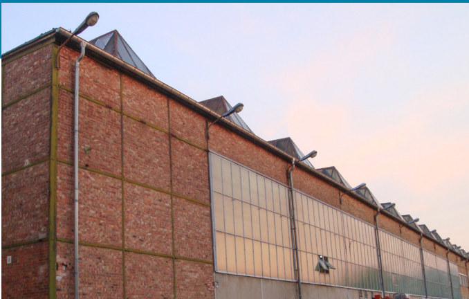
Alte Fassade der Fertigungshalle
