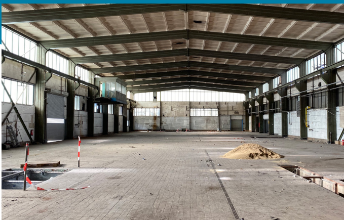
Das Betriebsgebäude vor der energetischen Sanierung
