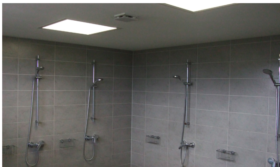
Mittels effizienter LED-Technik modernisierte Sanitärebereiche.
